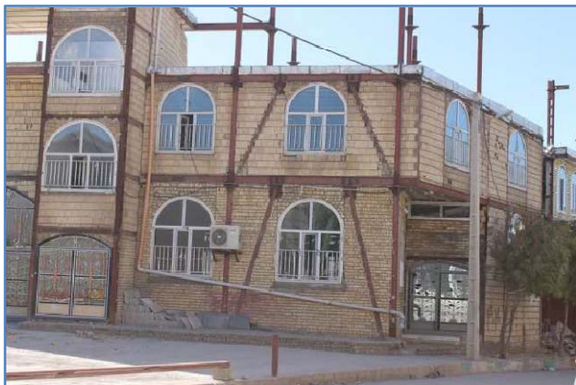
شکل ۹ - عملکرد مناسب مهاربندی خارج از مرکز
