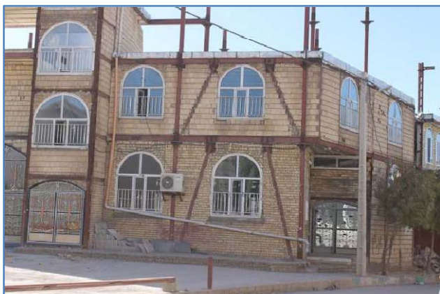
شکل ۹ - عملکرد مناسب مهاربندی خارج از مرکز
