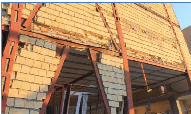
شکل ۱۰ - کمانش و پیچش تیر پیوند مهاربندی خارج از مرکز
