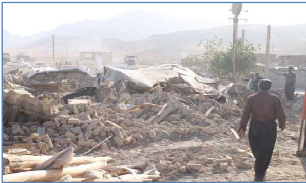
شکل ۱ - فروریزش ساختمان با مصالح بنایی
