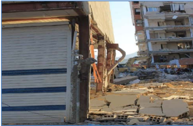
شکل ۴ - کماتش خارج از صفحه بادبند
