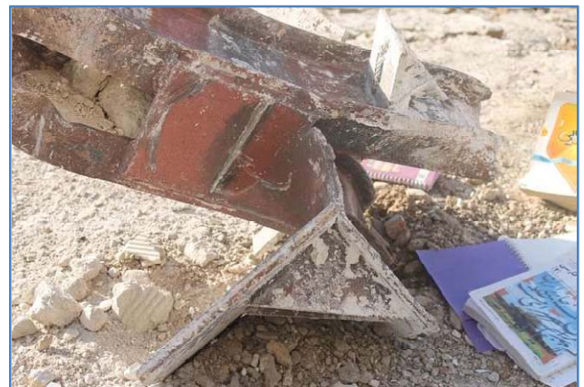
شکل ۷ - بریده شدن بست اتصال ستون
