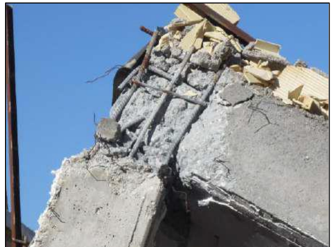
شکل ۷ - عدم کفایت قلاب انتهایی در تیر و ستون
