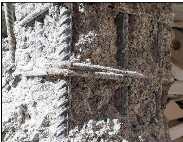
شکل ۵ - قلاب ۹۰ درجه بجای ۱۳۵ درجه
