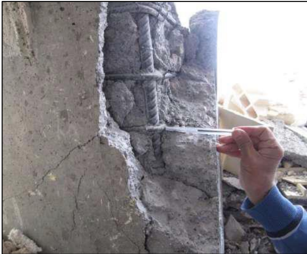
شکل ۴ - ضخامت بتن پوشش در مقایسه با طول خودکار
