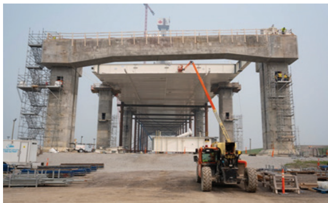
ستونها و تیرهای حجیم بتن آرمه در دهانه انتهایی پل
