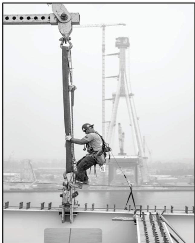
جزئیات اتصالات عرشه - ادوات اتصال برشی ملاحظه می شوند
