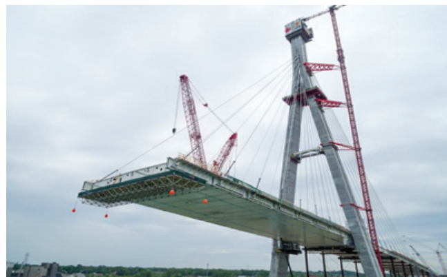
سیستم آویخته اجرای پل بصورت طره ای به کمک Bridge Builder
