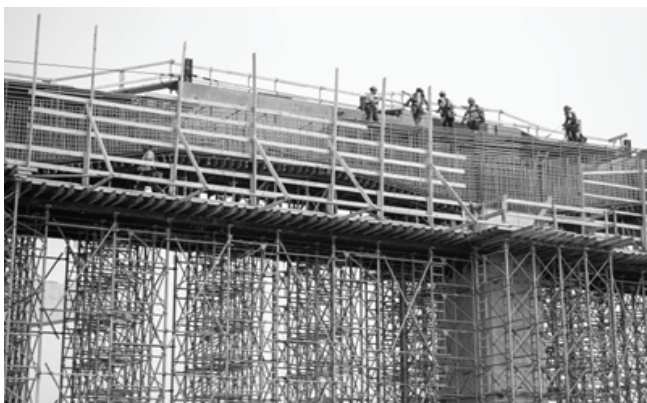
قالب بندی و آرماتوربندی مفصل در تیر و ستون پایه آخر پل
